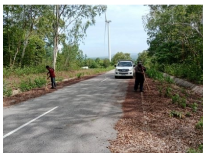
รูปที่ ค-3 โรงไฟฟ้าลำตะคองชลภาวัฒนาดำเนินการตรวจสอบสภาพรางระบายน้ำและแนวถนนตามแผนบำรุงรักษาโยธาเป็นประจำ โดยสำรวจเมื่อเดือนพฤษภาคม 2567 พบว่า สภาพถนนไหล่ทาง และรางระบายน้ำสภาพยังใช้งานได้ตามปกติ
